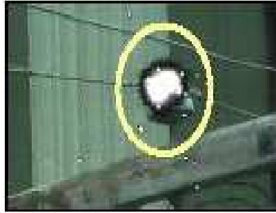
شکل - ۶: تصویر کرونای ناشی از مقره در شبکه توزیع که منجر به تولید اغتشاش رادیویی گردیده است.
