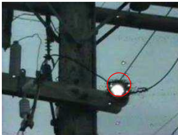
شکل ۴- تصویرکروناي ناشی از یک مقره چینی شکسته در روی خط ۲۰ کیلوولت
